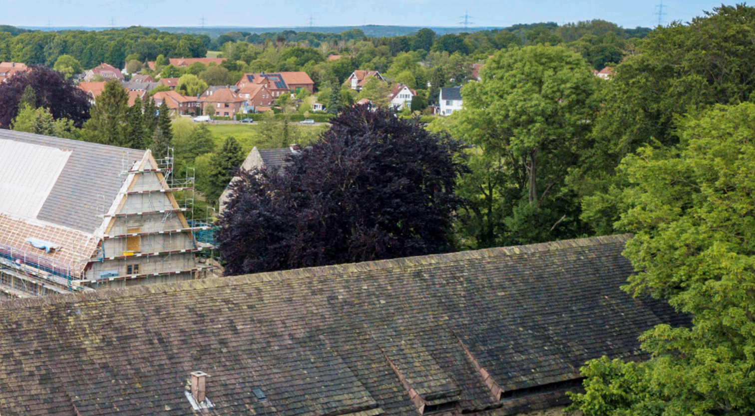
Die innere Klosteranlage von Loccum wird energetisch ertüchtigt. Dazu erhält das denkmalgeschützte Konventsgebäude aus dem Jahr 1780 eine Innendämmung. Die historischen Fenster werden erhalten. Um trotzdem Energie zu sparen, werden von innen zusätzliche Kastenfenster eingebaut.
